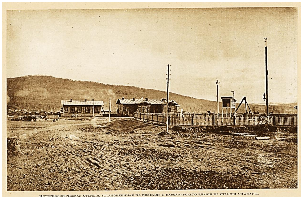
МЕТЕОРОЛОГИЧЕСКАЯ СТАНЦИЯ, УСТАНОВЛЕННАЯ НА ПЛОЩАДИ У ПАССАЖИРСКОГО ЗДАНИЯ НА СТАНЦИИ АМАВАРЬ.
